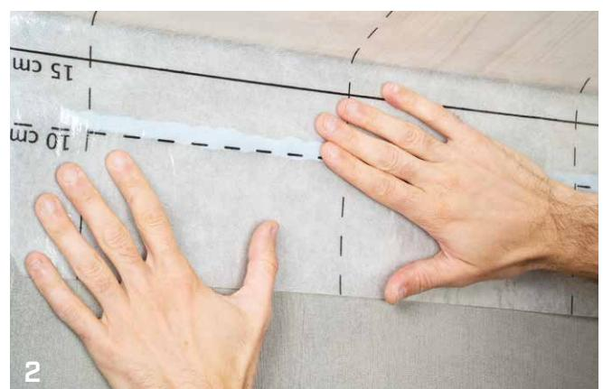
CONNESSIONE MEMBRANA IN COPERTURA - OSB
