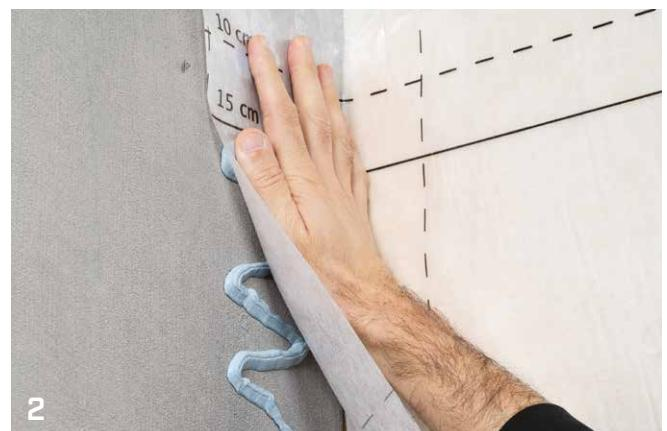
CONNESSIONE MEMBRANA IN COPERTURA - CALCESTRUZZO
